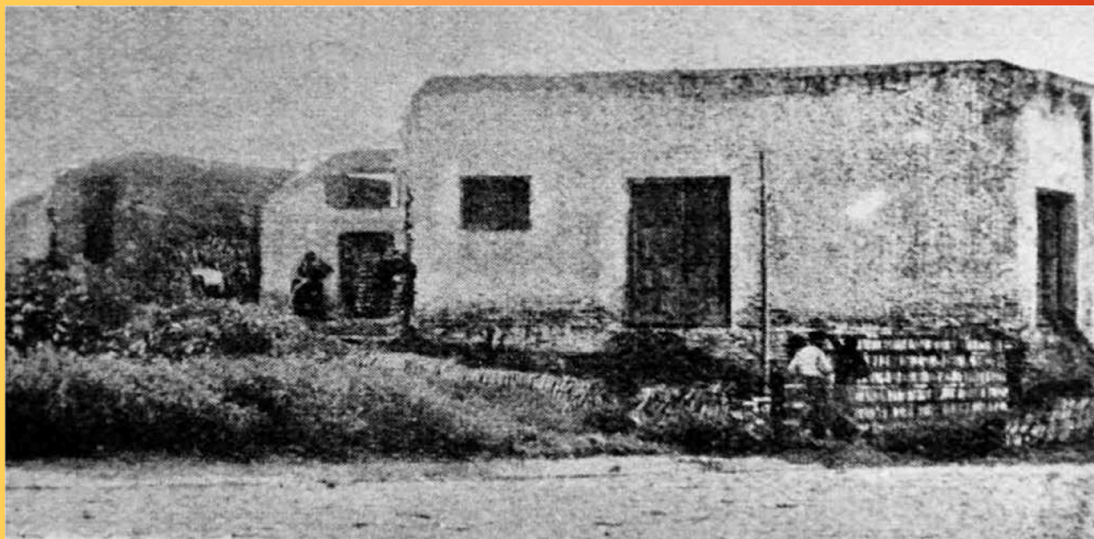
Caserío antes de su demolición. Periódico Rojo y Blanco (1902), en Bracco Boksar y López Mazz (2014)
